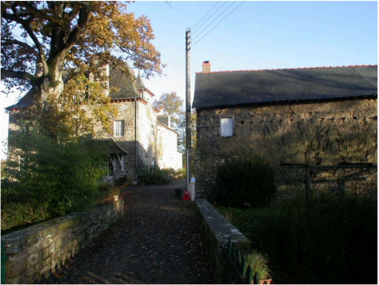
Pont enjambant les douves au sud
