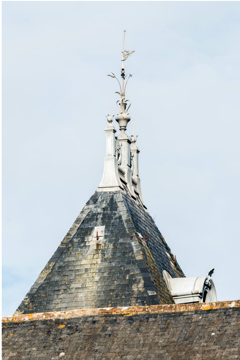
Détail d'un épi de faîtage, escalier nord
