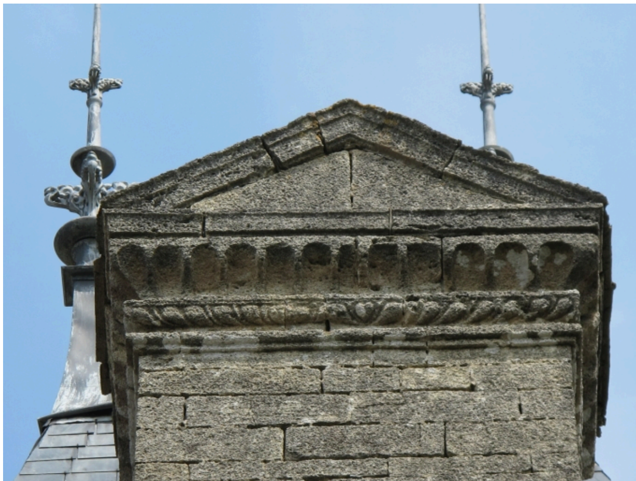
Souche de cheminée en calcaire des faluns, détail
