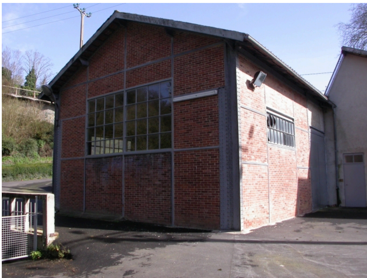
La salle des machines, vue générale nord-ouest.
