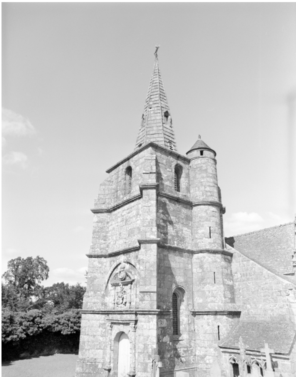
Deuxième niveau de la tour
