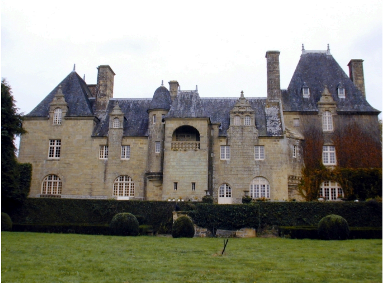
Vue générale de la façade postérieure
