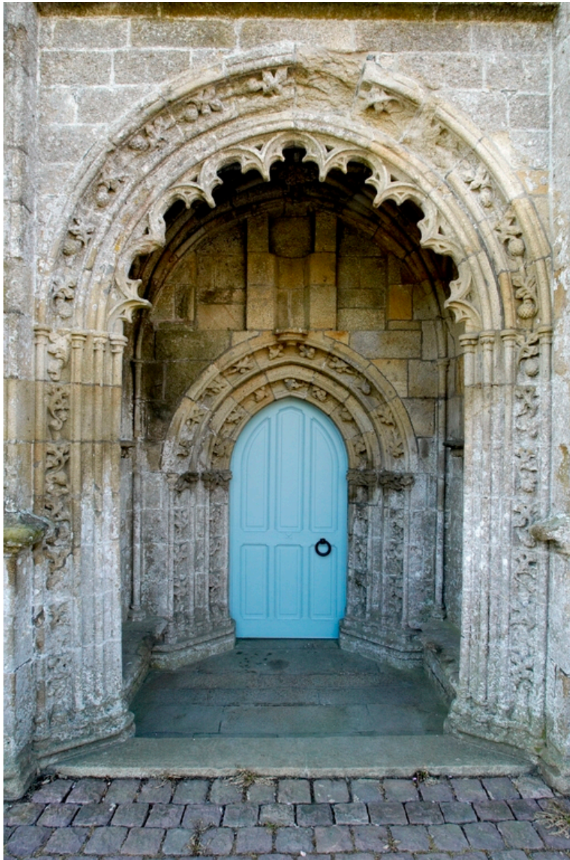
Vue rapprochée du porche nord.
