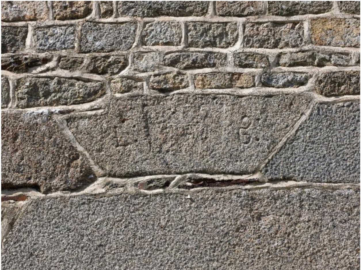
Façade antérieure, détail du linteau de la porte d'entrée avec armoiries bûchées.
