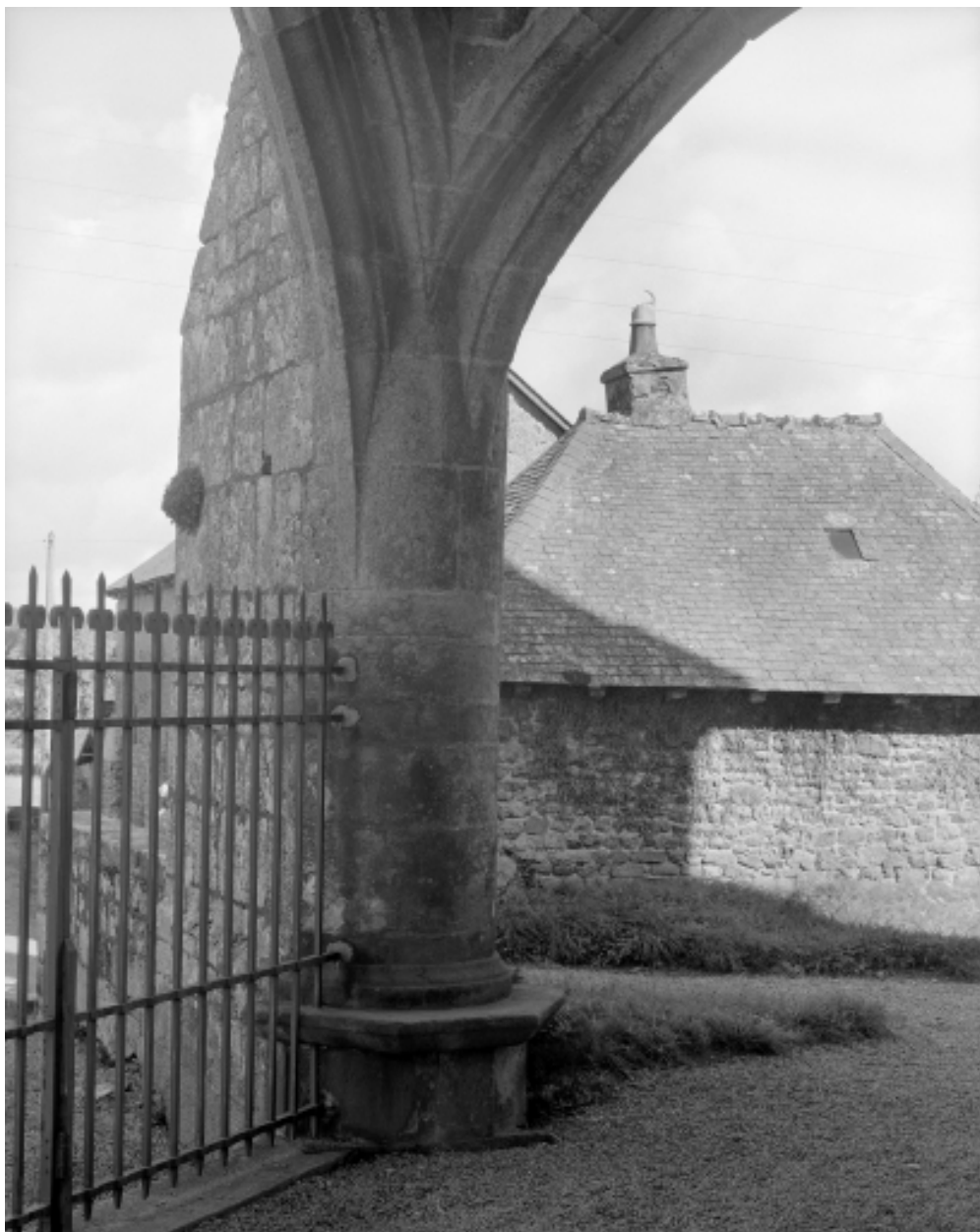
Porche occidental, pile nord-ouest et départ de voûtement.
