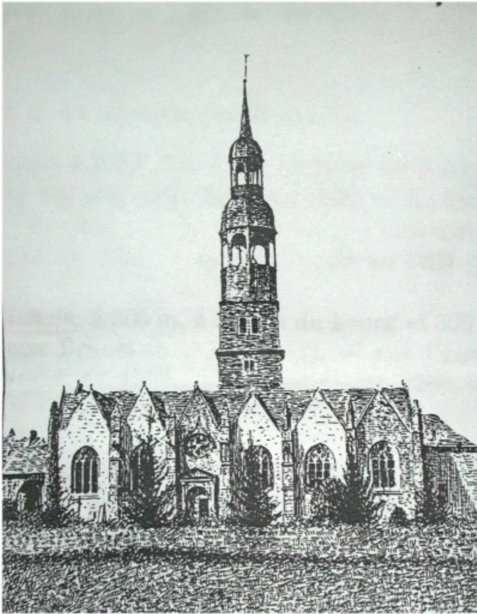
L'ancienne église à la fin du 19e siècle
