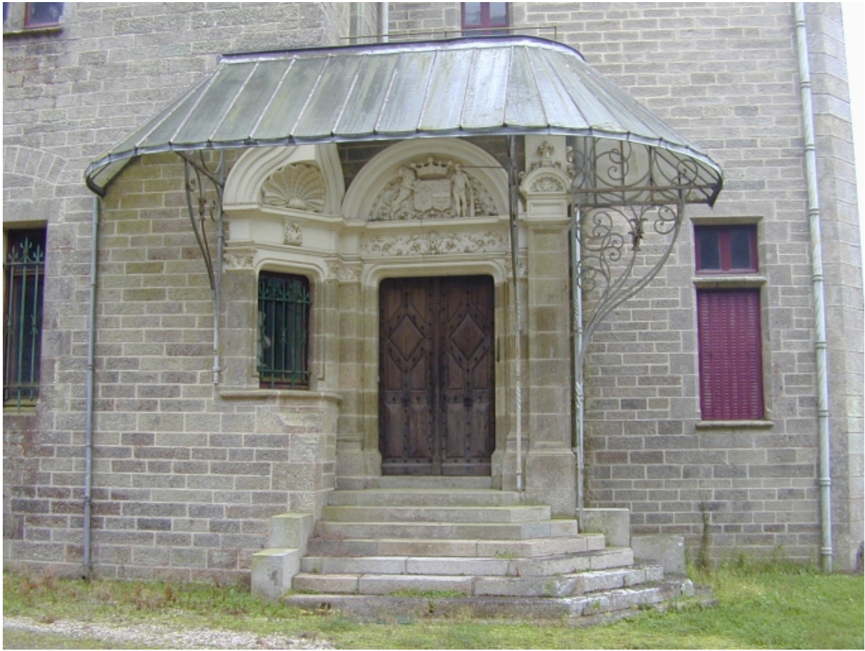
La porte principale coiffée d'une marquise : vue générale nord
