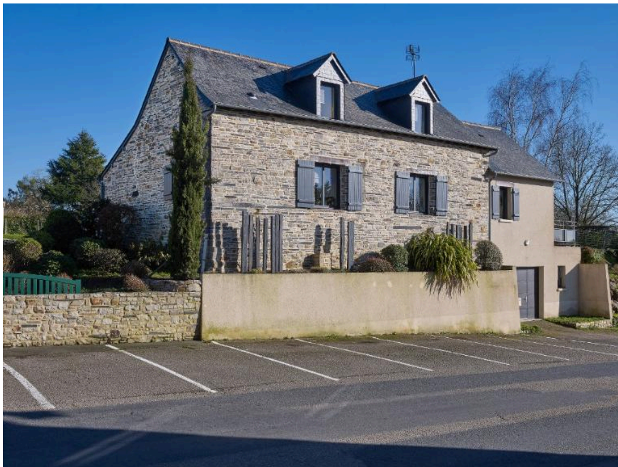
Façade ouest de la maison du 2 rue de la Mairie, après réhabilitation
