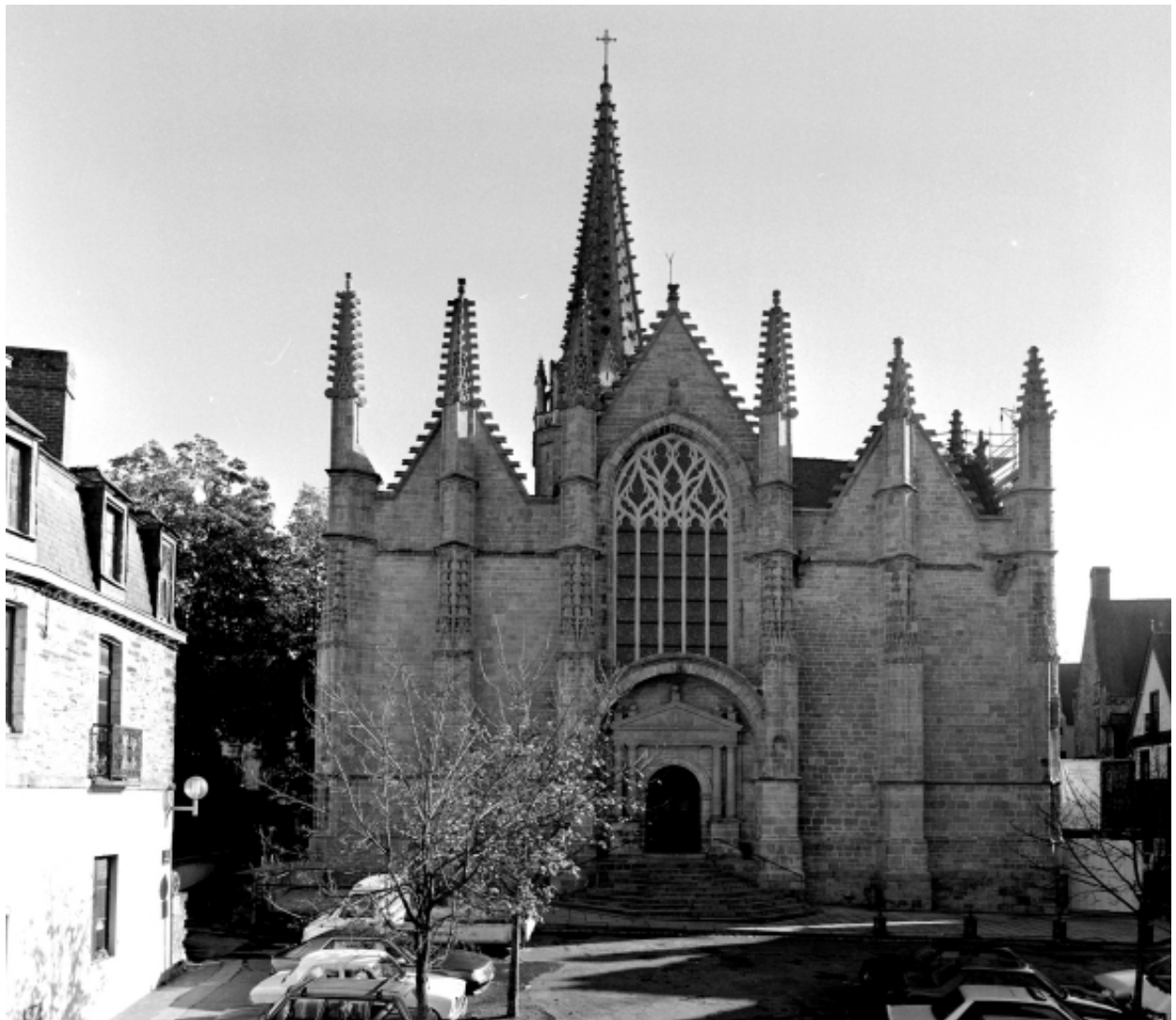
Elévation ouest : vue générale.
