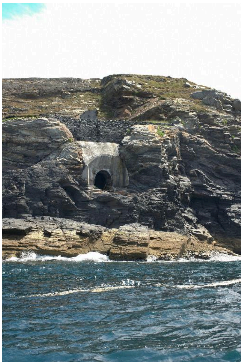
Roscanvel : vue de l'ensemble fortifié de l'îlot des Capucins depuis la mer, face nord, abri sous roc du projecteur
