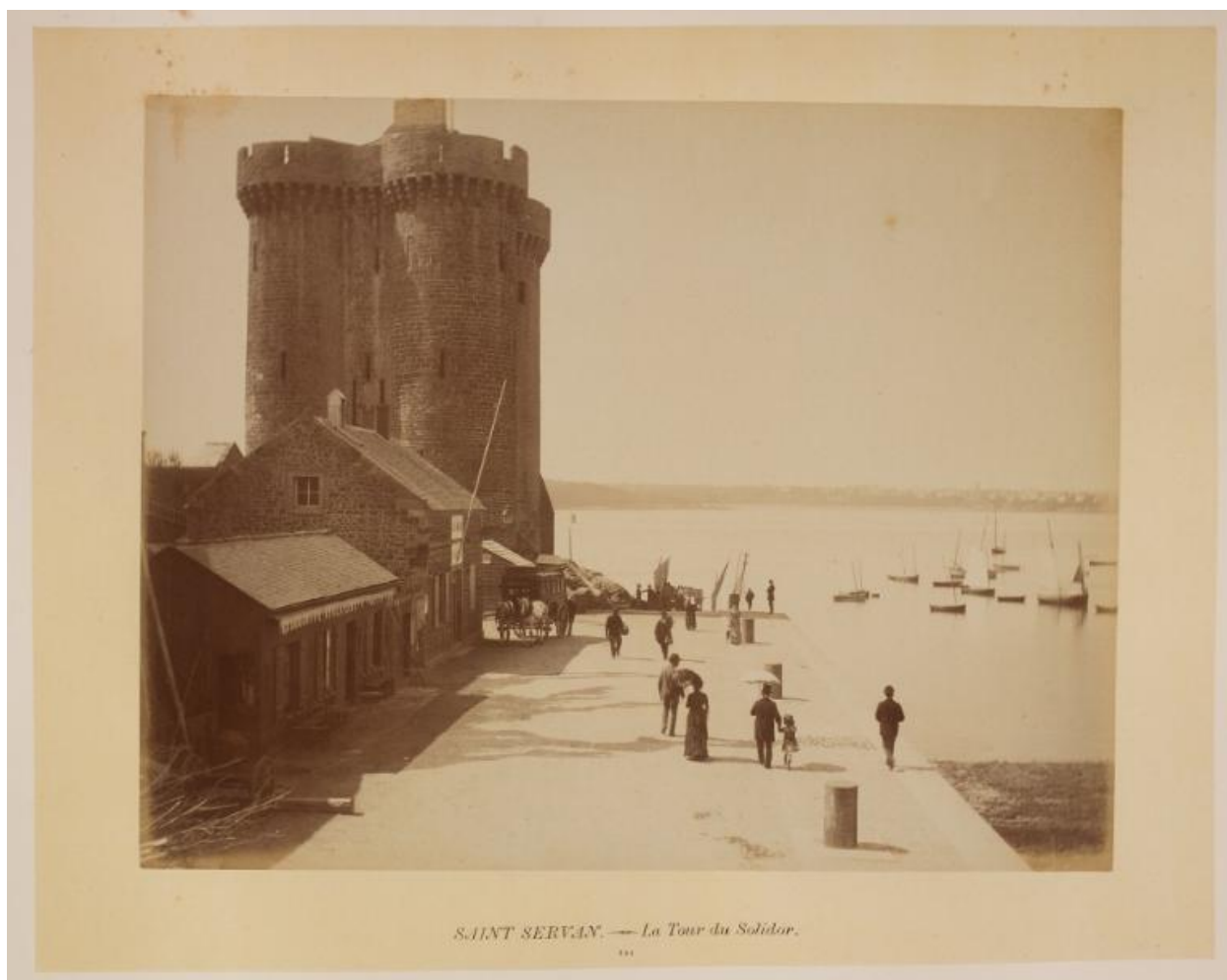
Vue de la Tour Solidor avant sa restauration, vers 1885
