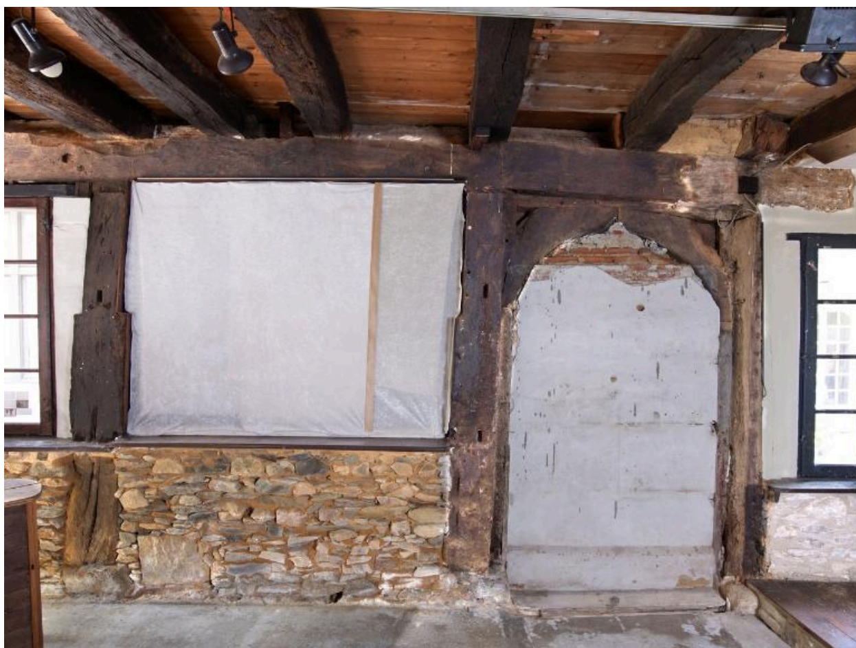
Rez-de-chaussée. Mur gouttereau nord. Porte centrale et poteau d'huissierie
