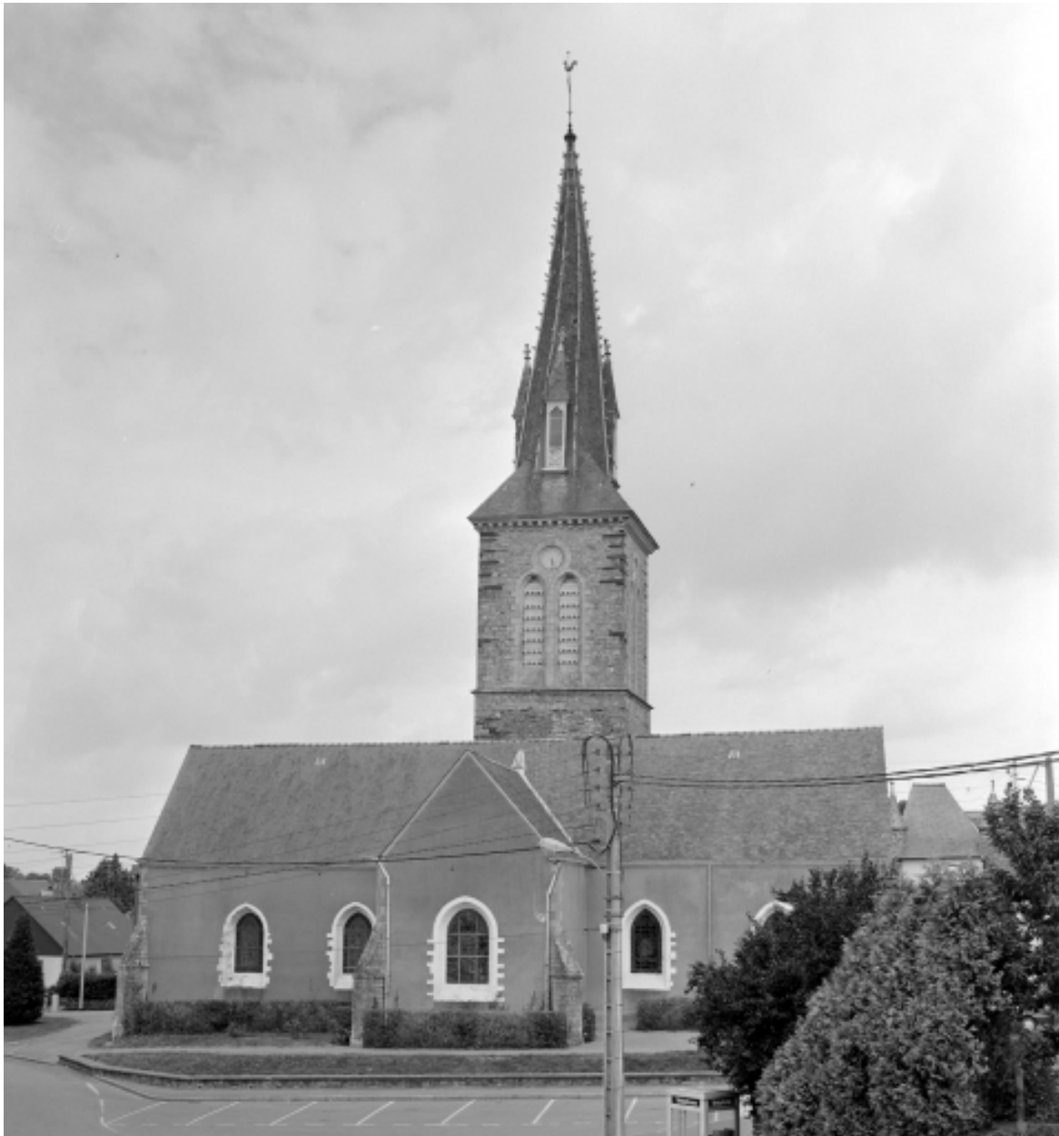
Elévation Sud : vue générale (état en 1994)
