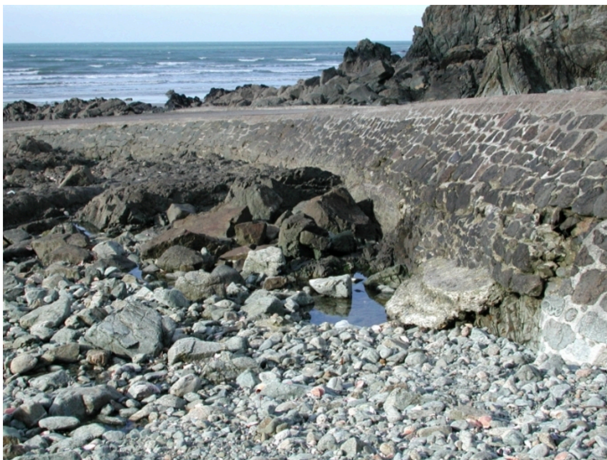
Vue de la partie convexe de la cale et des enrochements de façade
