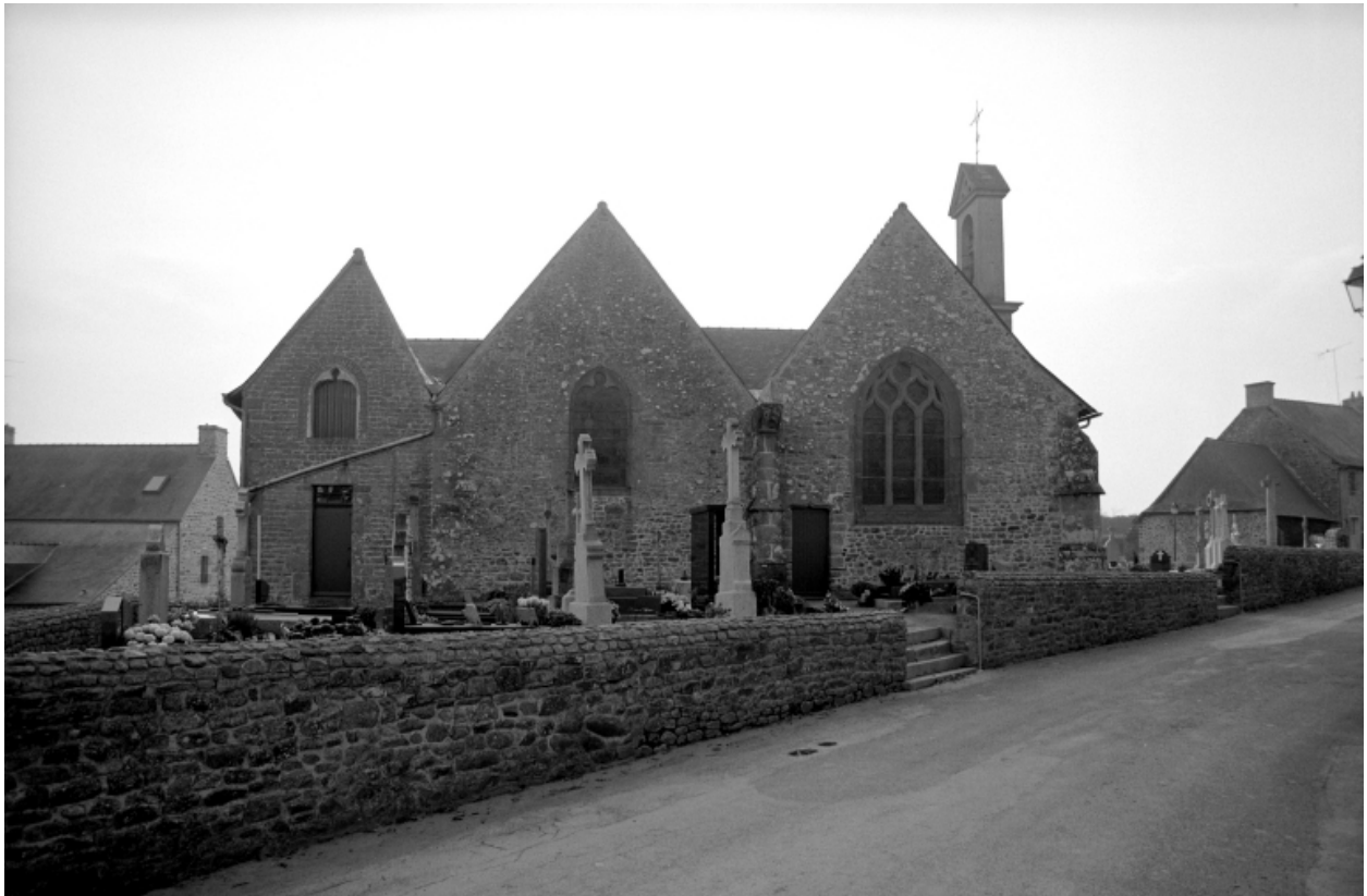
Elévation Nord : vue générale
