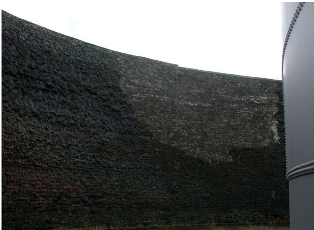
Vue du parc à carburant de Maison Blanche : encuvement en moellon et cuve métallique (à droite)
