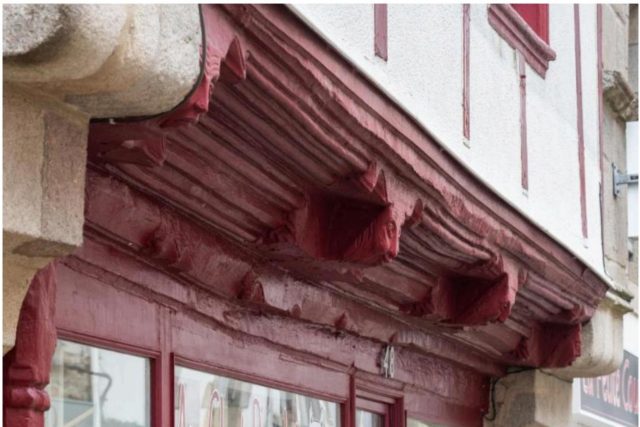
L'encorbellement se compose de deux sablières et d'entretoises, moulurées avec congés. Le décor porté sur la sablière de plancher souligne la disparition des poteaux centraux, positionnés sous les solives.
