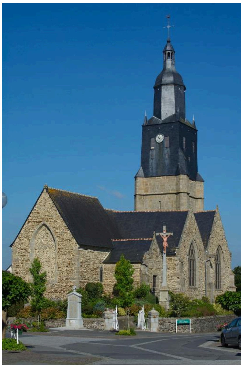
Vue générale nord-est
