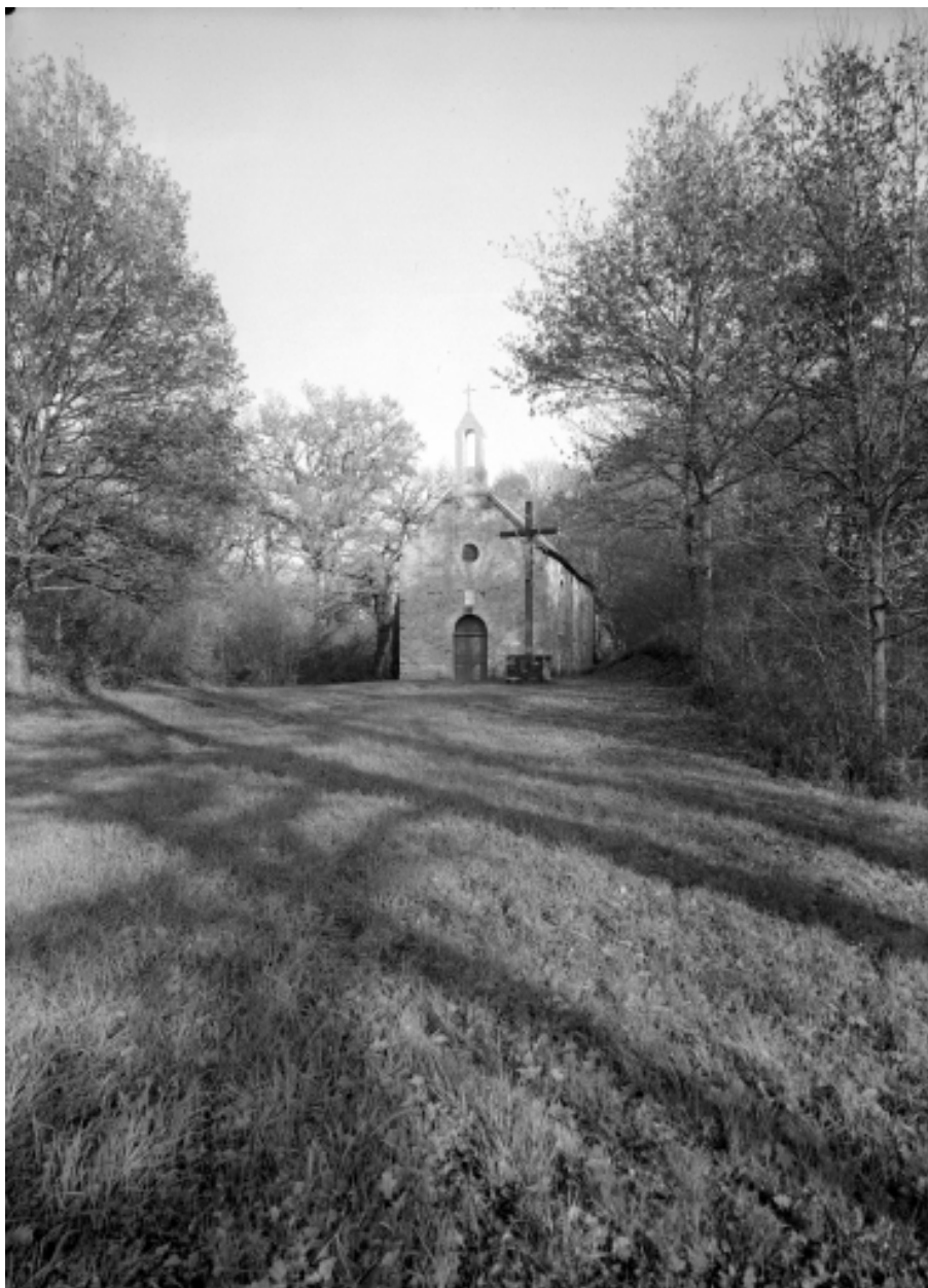
Elévation Ouest : vue de situation
