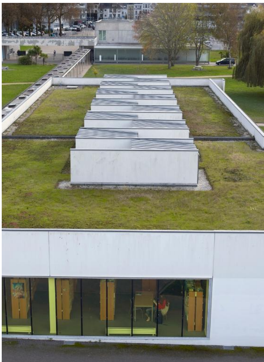
Toitures et baies de l'étage du CDI (P. Debard et S. Bertic, architectes, ca. 2005).
