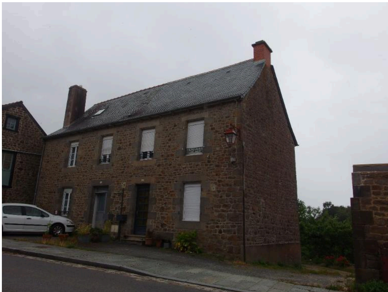
Vue de la façade est
