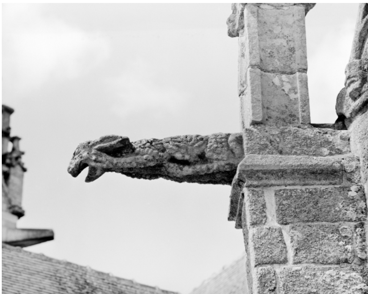
Elévation sud, vue de détail de gargouille.
