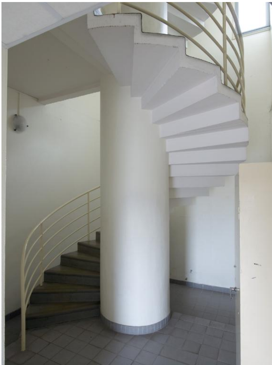
Escalier en vis dans la tourelle.
