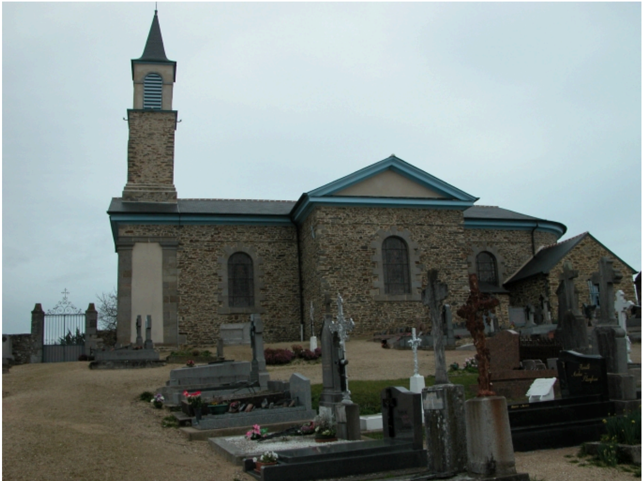
Elévation Sud : vue générale
