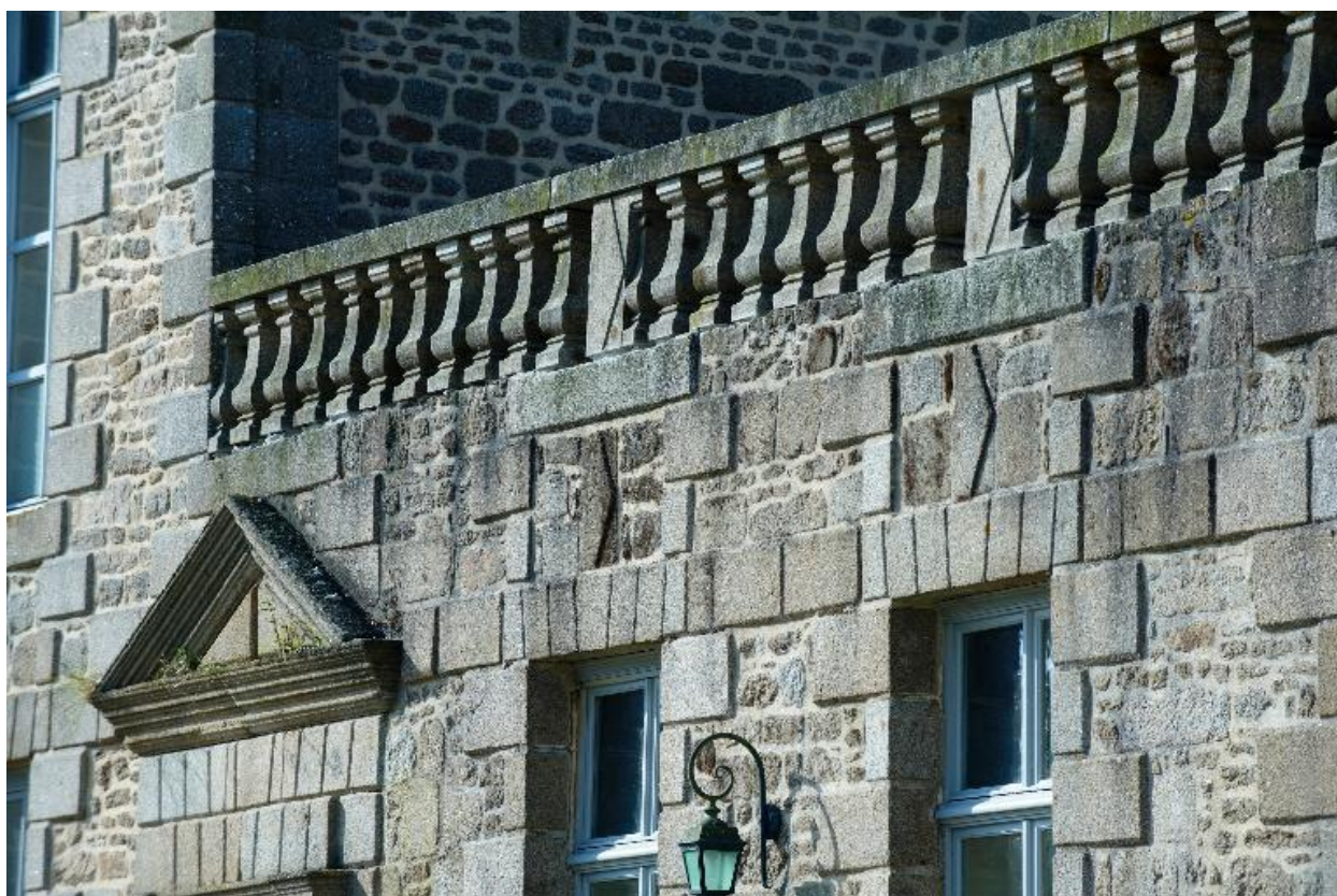
Détail de maçonnerie
