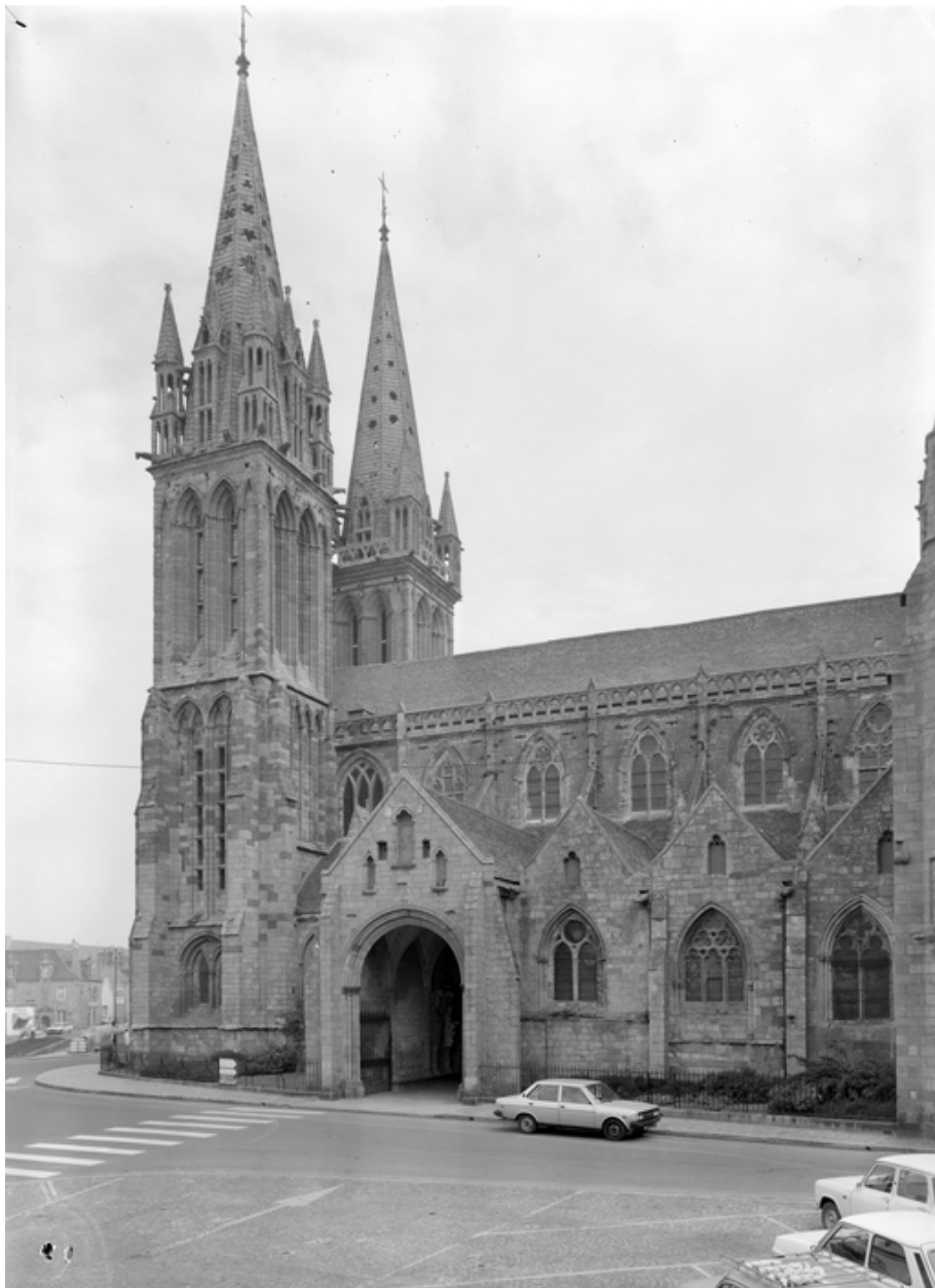
Vue générale sud du porche et du clocher
