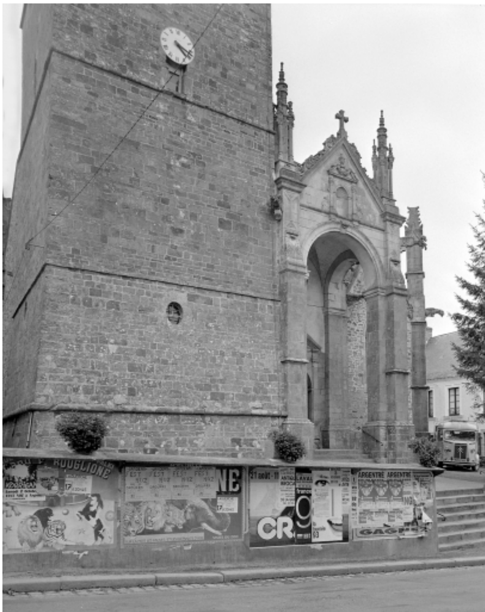
Elévation ouest, partie basse : vue générale
