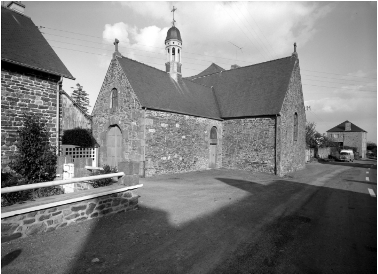
Elévation Sud-Ouest : vue générale
