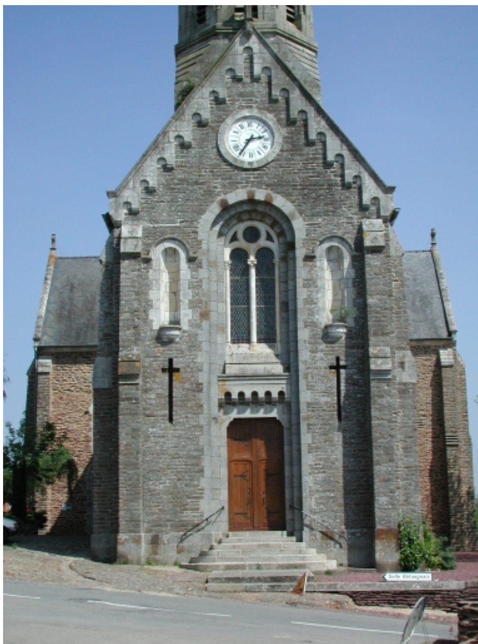
Vue partielle ouest
