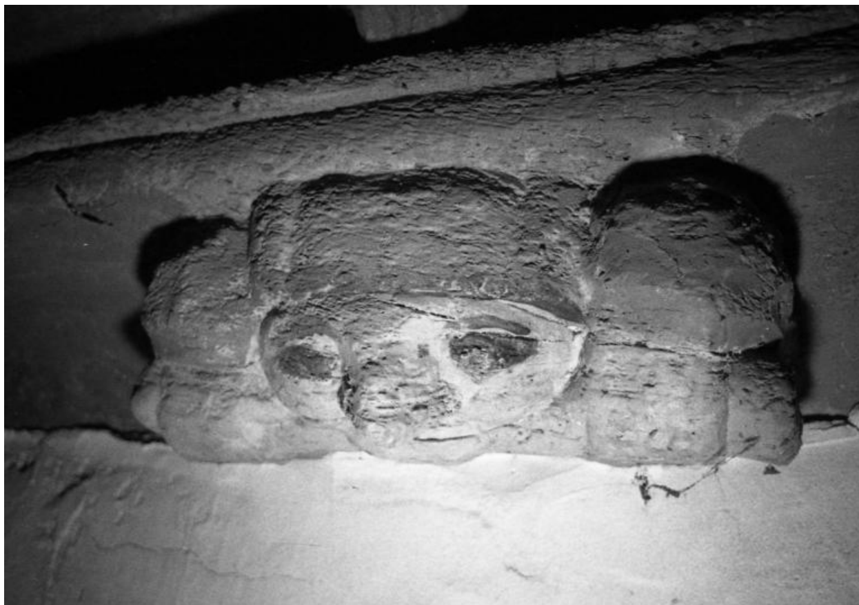
Détail de sablière, côté ouest.
