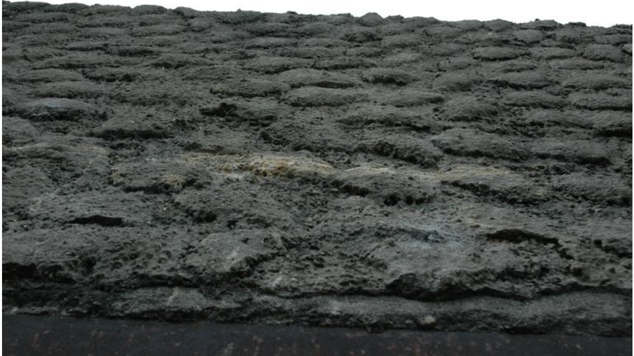
Vue du bunker-casemate nord : détail du traitement texturé du béton à des fins de camouflage (état en 2008)
