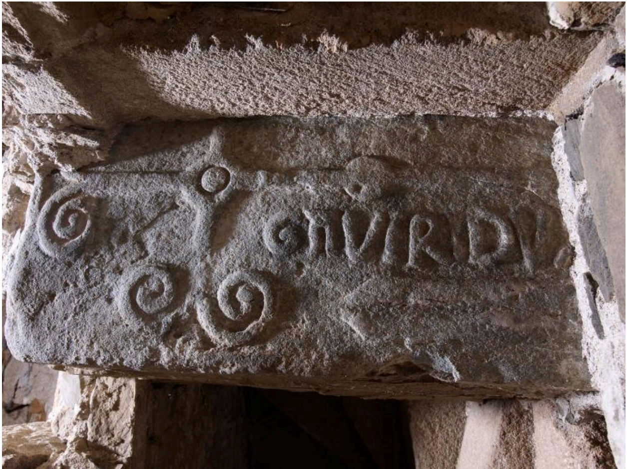
Construction d'angle nord-est. Sas de la tour d'escalier. Détail de la dalle funéraire remployée en dallage de plafond : croix recerclée accompagnée de l'inscription GAUFRIDUS, recteur de La Roche-Derrien, 2e quart du 14e siècle
