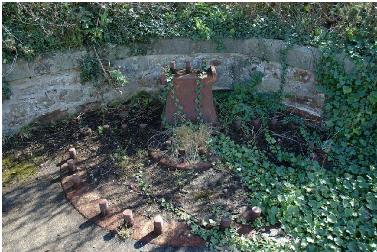
Vue de l'une des six plate-formes de tir : sous-selle d'affût (état en 2007)
