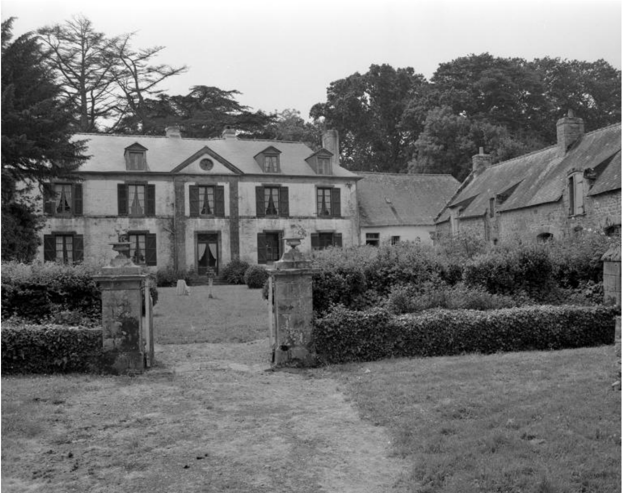
Vue générale nord
