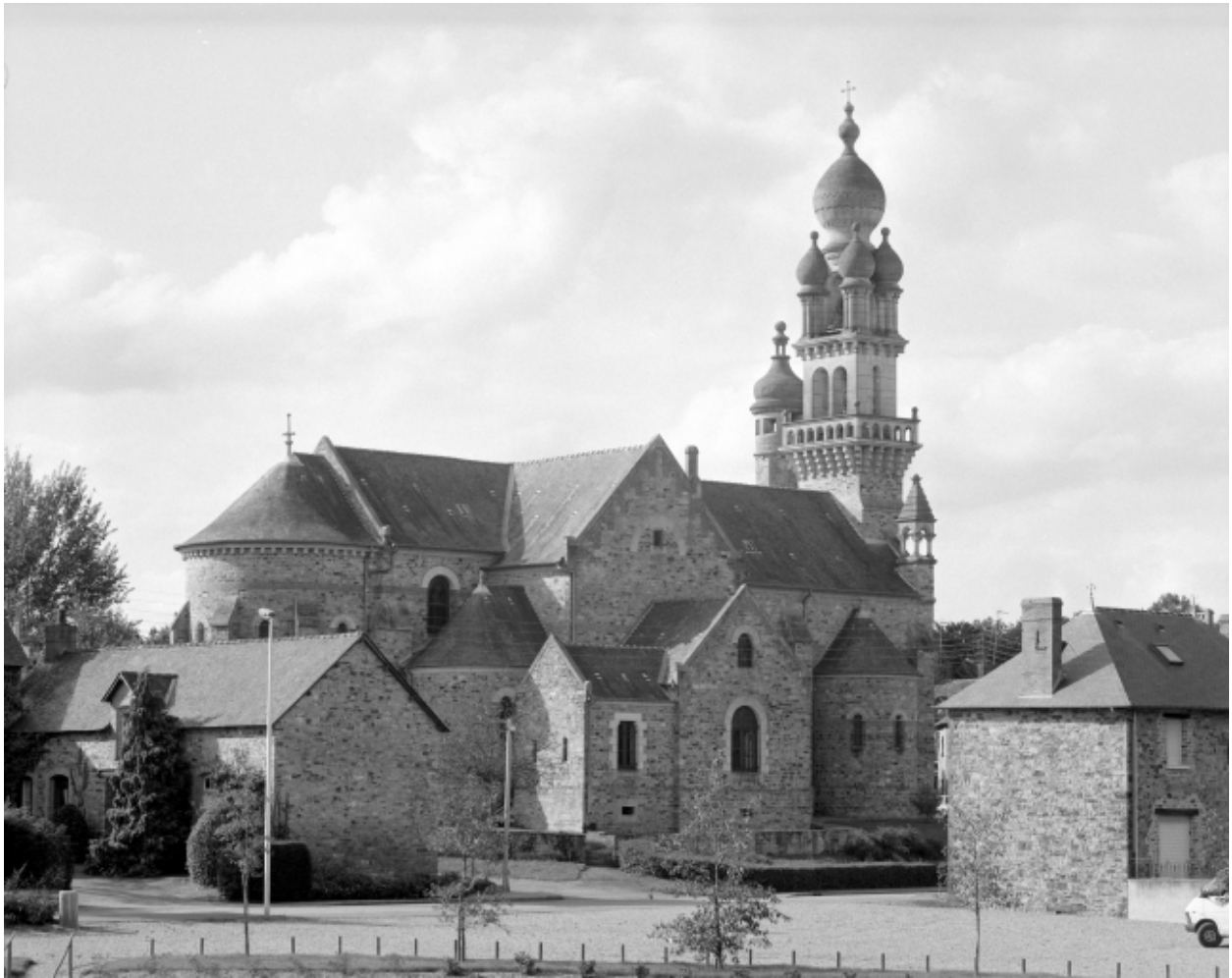
Elévation Sud-Est : vue générale
