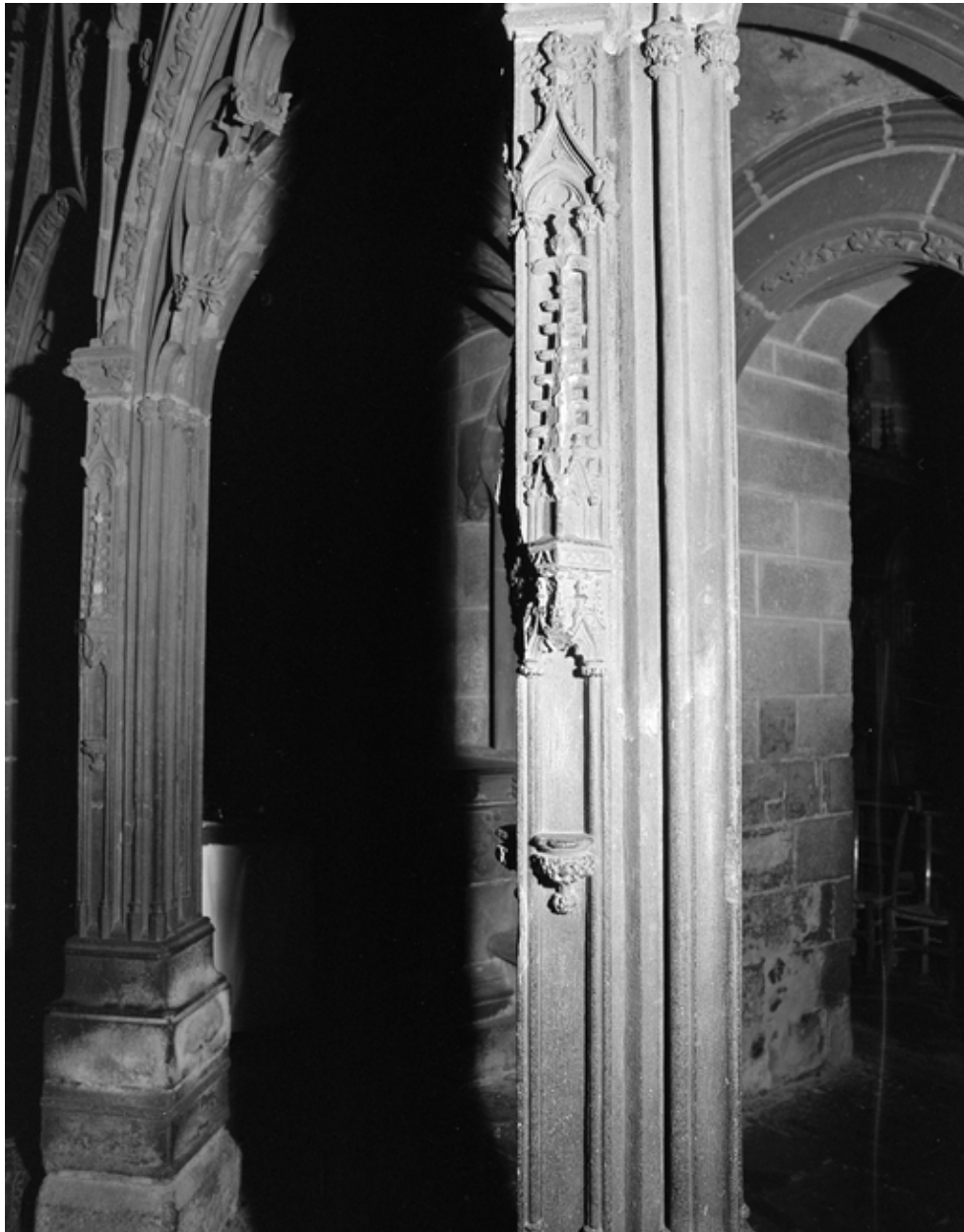
Jubé, détail de niche sur poteaux
