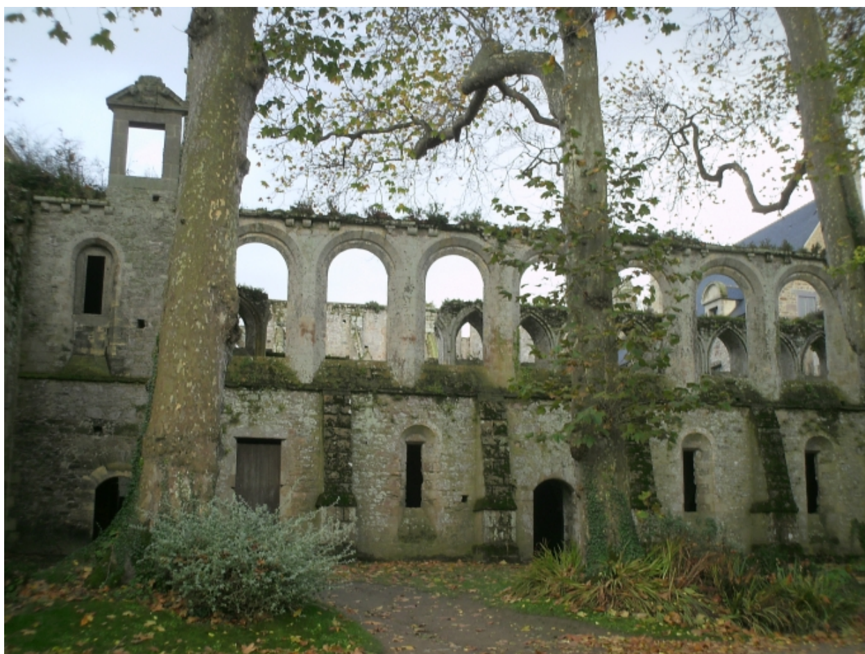
Le bâtiment abritant le grand cellier et le réfectoire, façade nord
