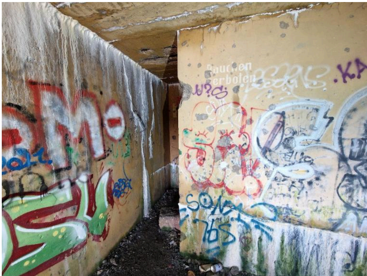
Vue intérieure du bunker - cuve nord pour canon de 34 cm avec magasins de munitions. Ce bunker conserve sa peinture ocre jaune et des marquages
