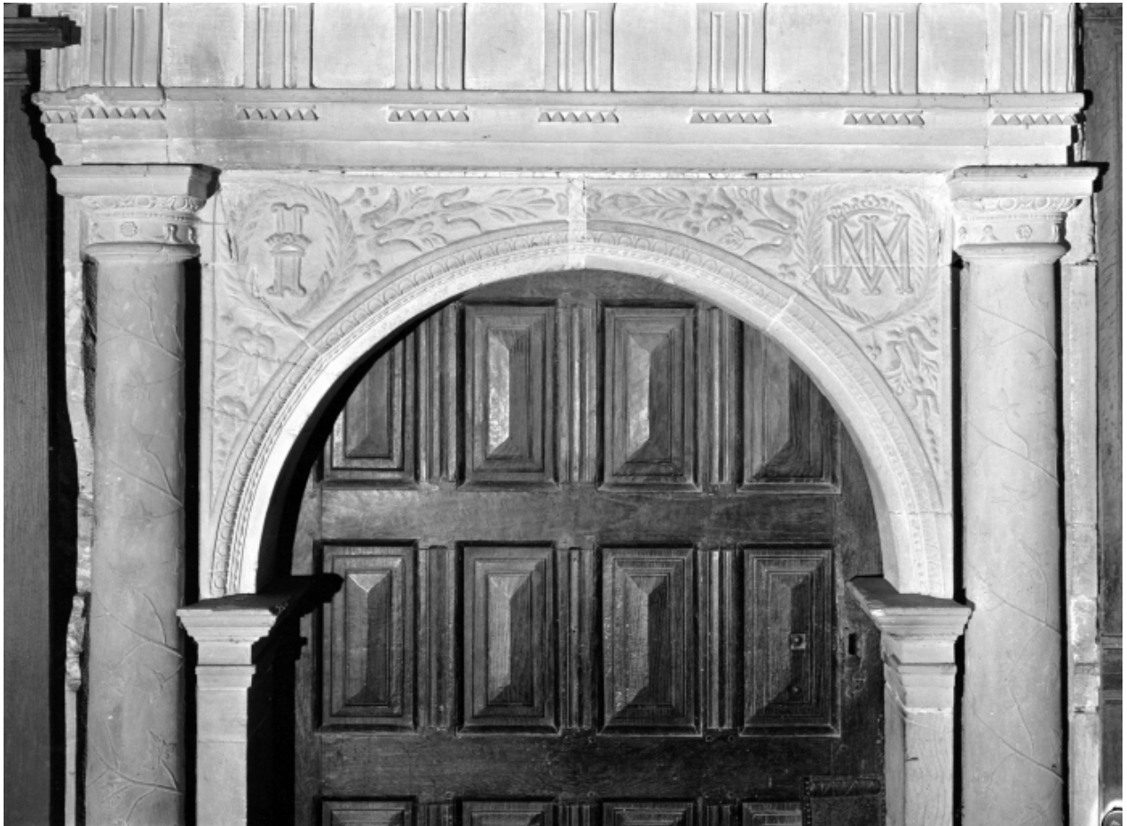
Porte sud de la sacristie, détail partie supérieure des colonnes
