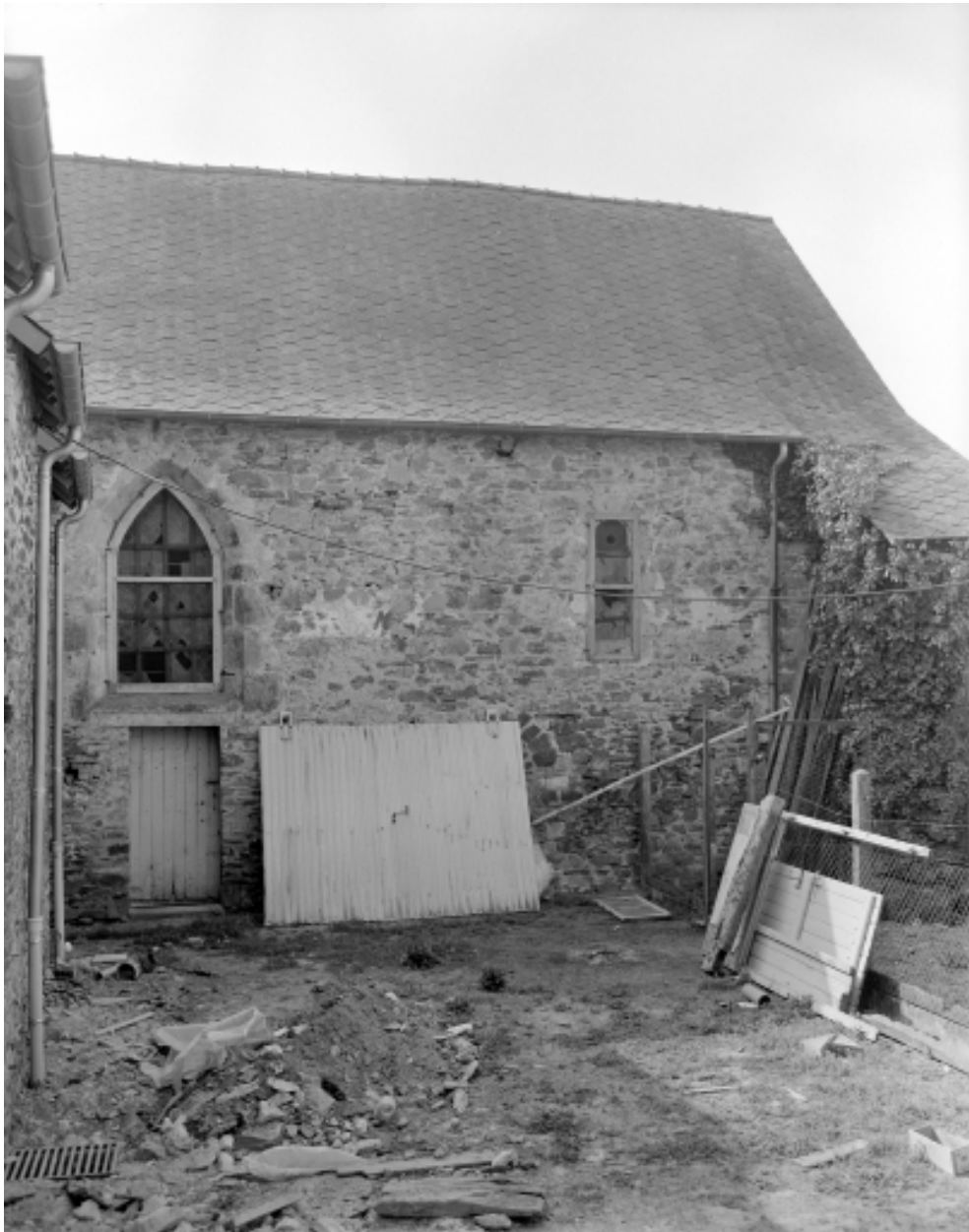
Elévation latérale, vue générale.
