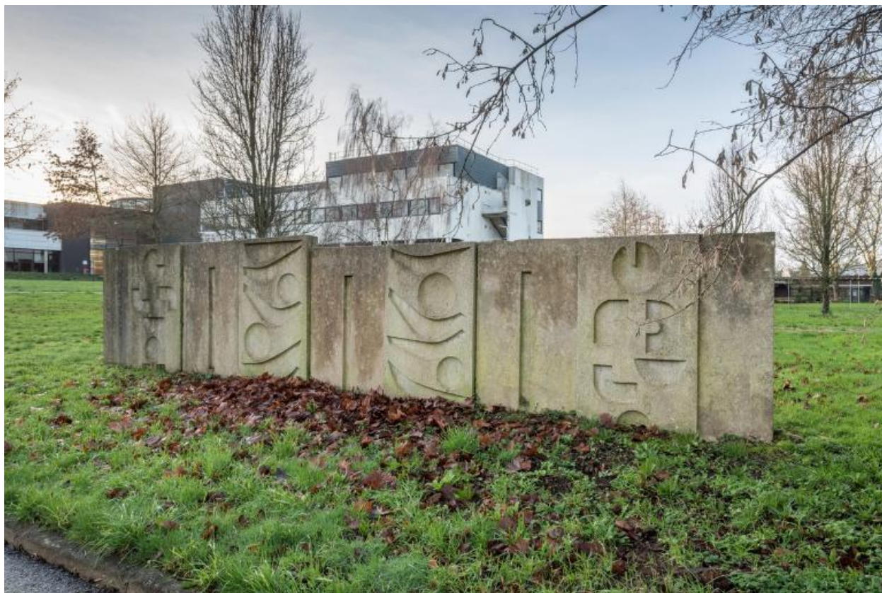
Vue d'ensemble du mur sculpté continu (Edgard Pillet, 1970), prise du nord. A l'arrière plan, un bâtiment d'externat de 1997.
