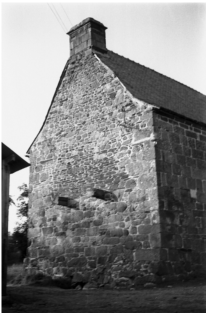
Façade nord ouest : corps de bâtiment au sud ouest, élévation
