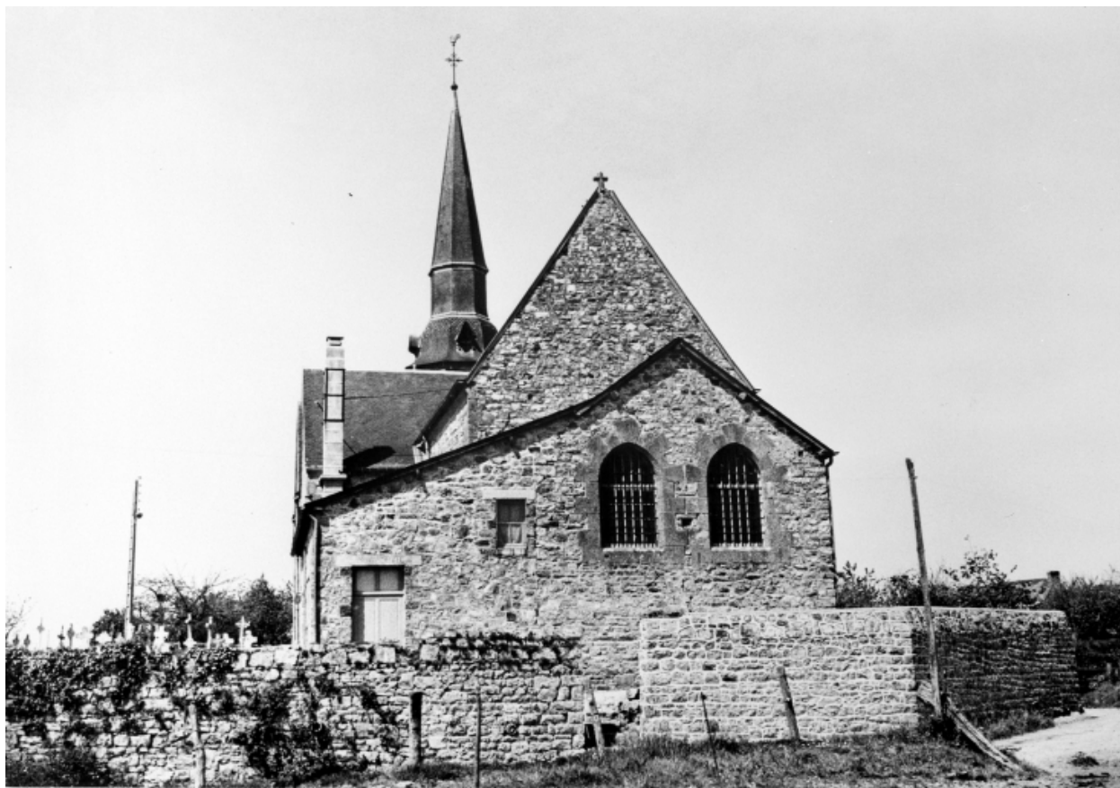
Élévation Est : vue générale
