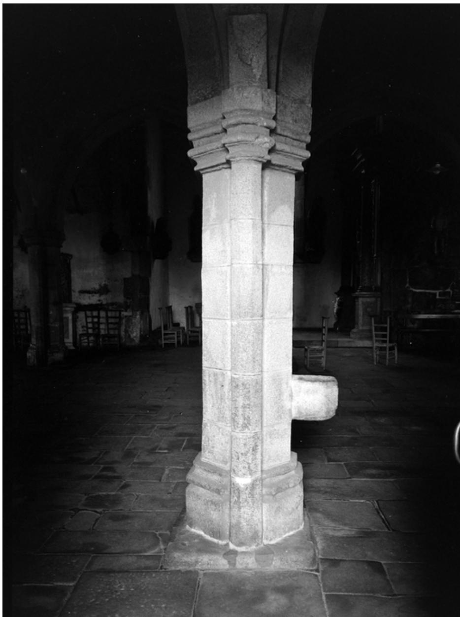
Nef : vue du pilier sud n°4
