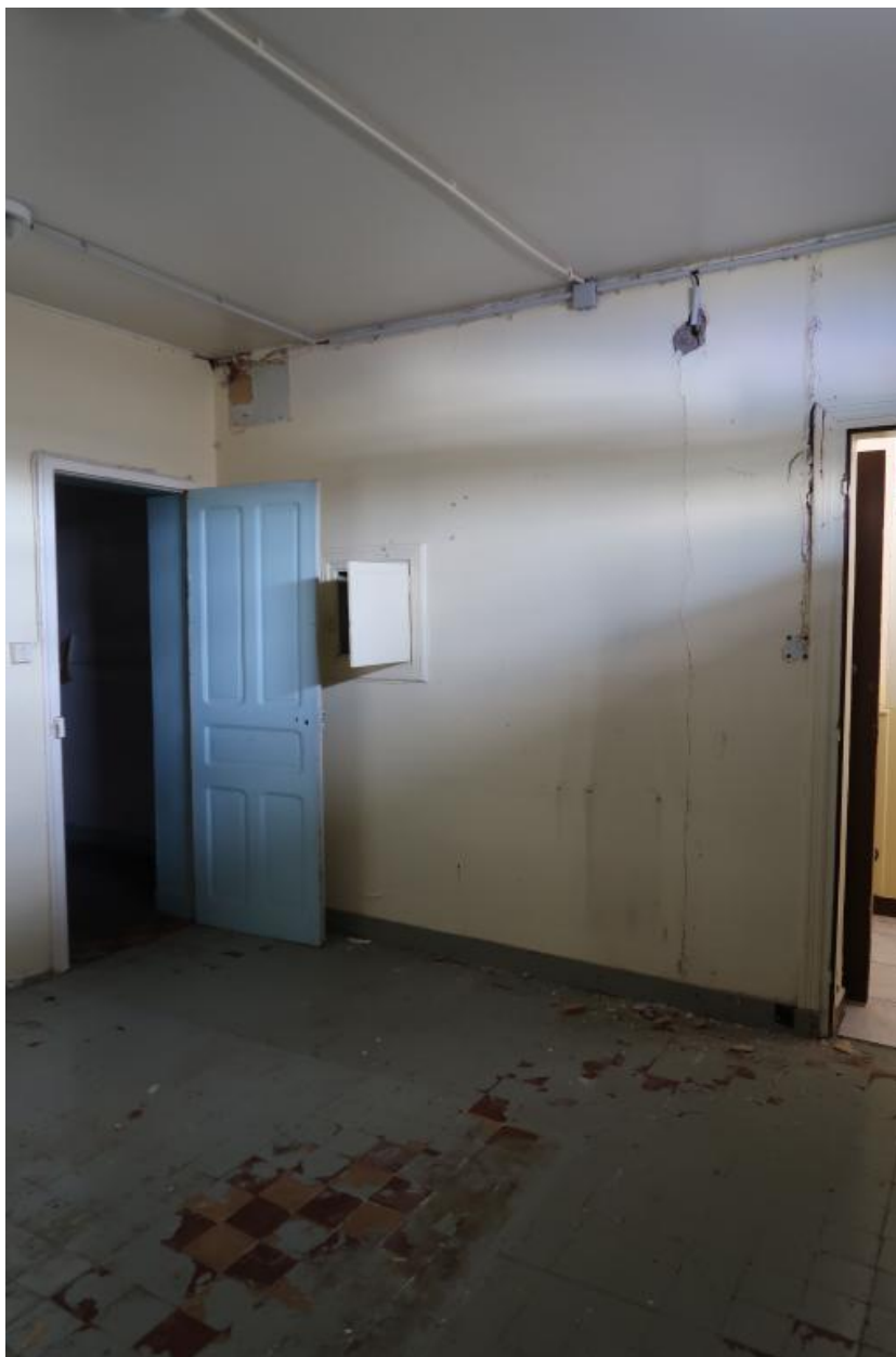
Intérieur, rez-de-chaussée, sol carrelé
