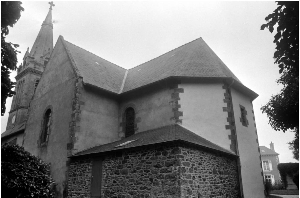
Vue oblique, ensemble sud de l'église
